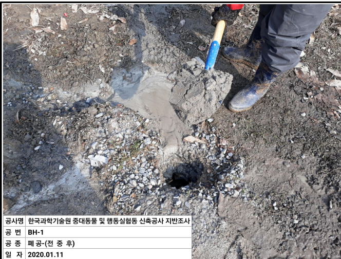
공사명 한국과학기술원 중대동물 및 행동실험동 신축공사 지반조사 공 번 BH-1 공 종 폐공-(전 중 후) 일 자 2020.01.11
